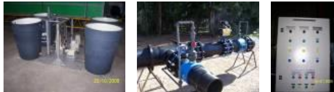
Kit de Dosificación, punto de inyección y su respectivo tablero de comando y control
