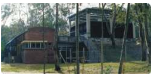
Planta Depuradora El Tesoro (1993). Maldonado, Uruguay. 350 m 3 /h-20.000 habitantes
