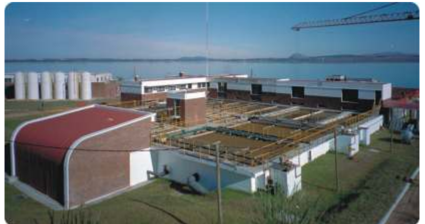
Planta Potabilizadora Laguna del Sauce (1994). Maldonado, Uruguay. Ampliación a 2m 3 /s - 650.000 habitantes.
