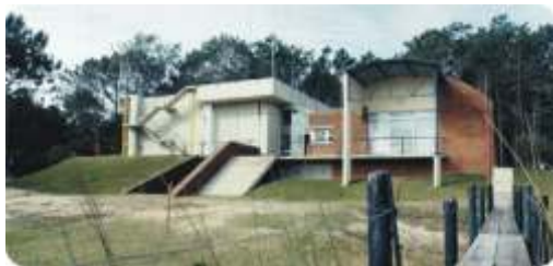
Planta Potabilizadora Laguna Blanca (1993). Maldonado, Uruguay. 500 m 3 /h-25.000 habitantes
